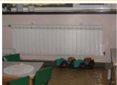
Нова отоплителна инсталация в детска ясла след проекта
