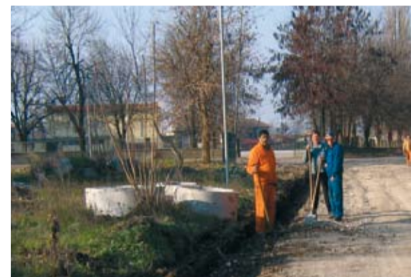
ул. „Захари Зограф“ по време на ремонта
