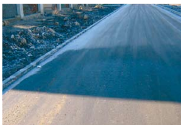
ул. „Явор“ с ново асфалтово покритие
