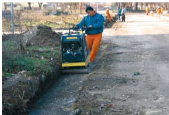
ул. „Захари Зограф“ по време на ремонта
