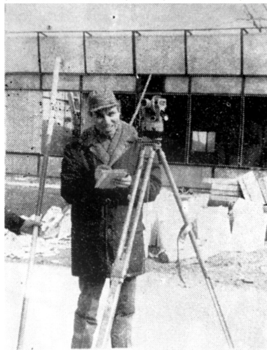
Конкурсна снимка отразява строителни работи в града
